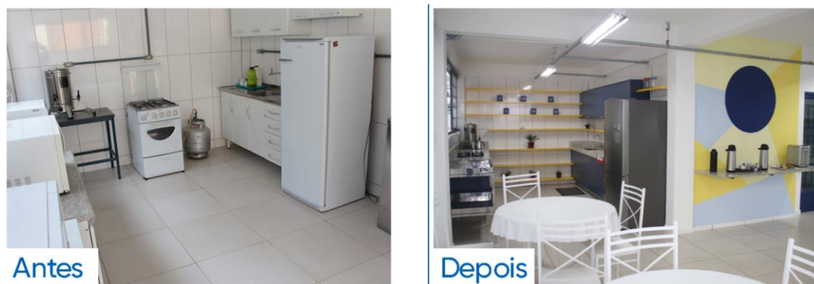
Figura 16 - Reforma do refeitório dos funcionários
