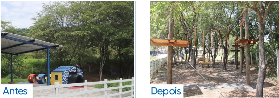
Figura 17 - Construção da área de arborismo no centro veterinário
