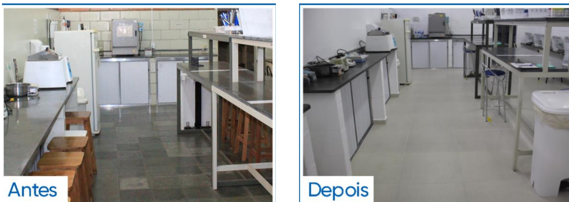
Figura 15 - Troca de piso do laboratório de análises clínicas
